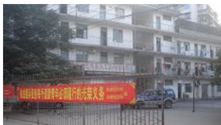
图 1 注浆抬升试验楼
